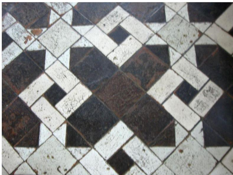
Pour en saisir l'aspect général, il est nécessaire de reconstruire ce pavage sur une surface plus grande à l'aide des lois de la science appelée cristallographie. Ce schéma, facile à produire, est tourné de 45 degrés par rapport à la photographie, il correspond aux directions de travail du carreleur ( fig. 1 ).
